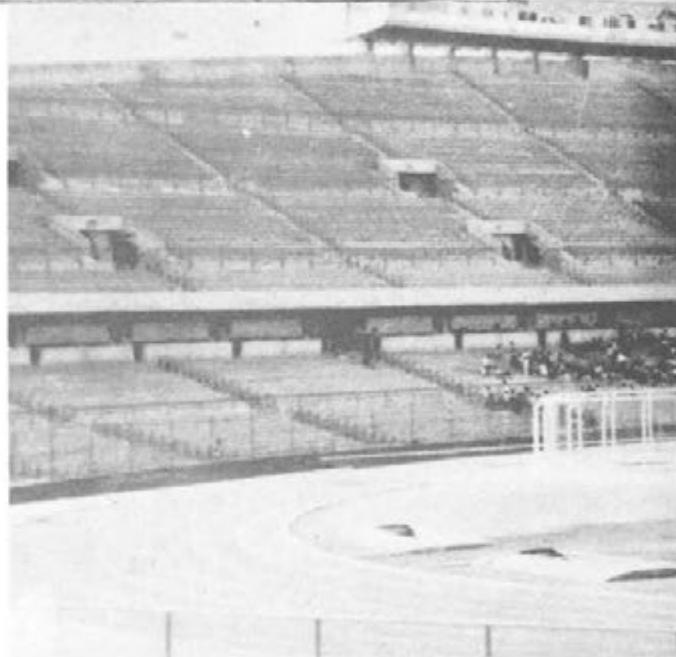
laterales, para los saques de banda. El césped lo forma una combinación de cinco clases de pastos y fué sembrado sobre una capa de cuarenta centímetros de tierra lama, la cual queda a su vez sobre un filtro de piedra basáltica de diversos tamaños, de mayor a menor y de abajo arriba, que permite que el agua de lluvia sea eliminada con rapidez.
