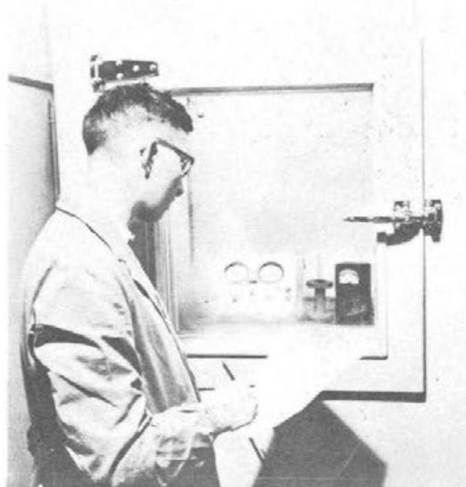
*En los Laboratorios Omega, los aparatos de cronometraje Omega utilizados en los juegos Centroamericanos fueron sometidos a pruebas muy severas. Después de haber sido puesto en una estufa de más de + 60° C. este aparato universal de 2 contadores está controlado en una nevera con una temperatura de menos de - 40° C.*
