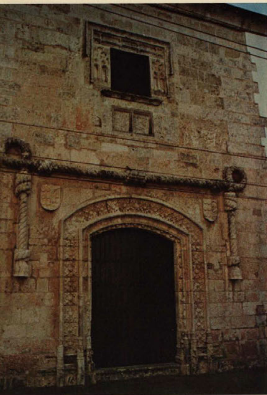
Portal de la famosa Casa del Cordón.
