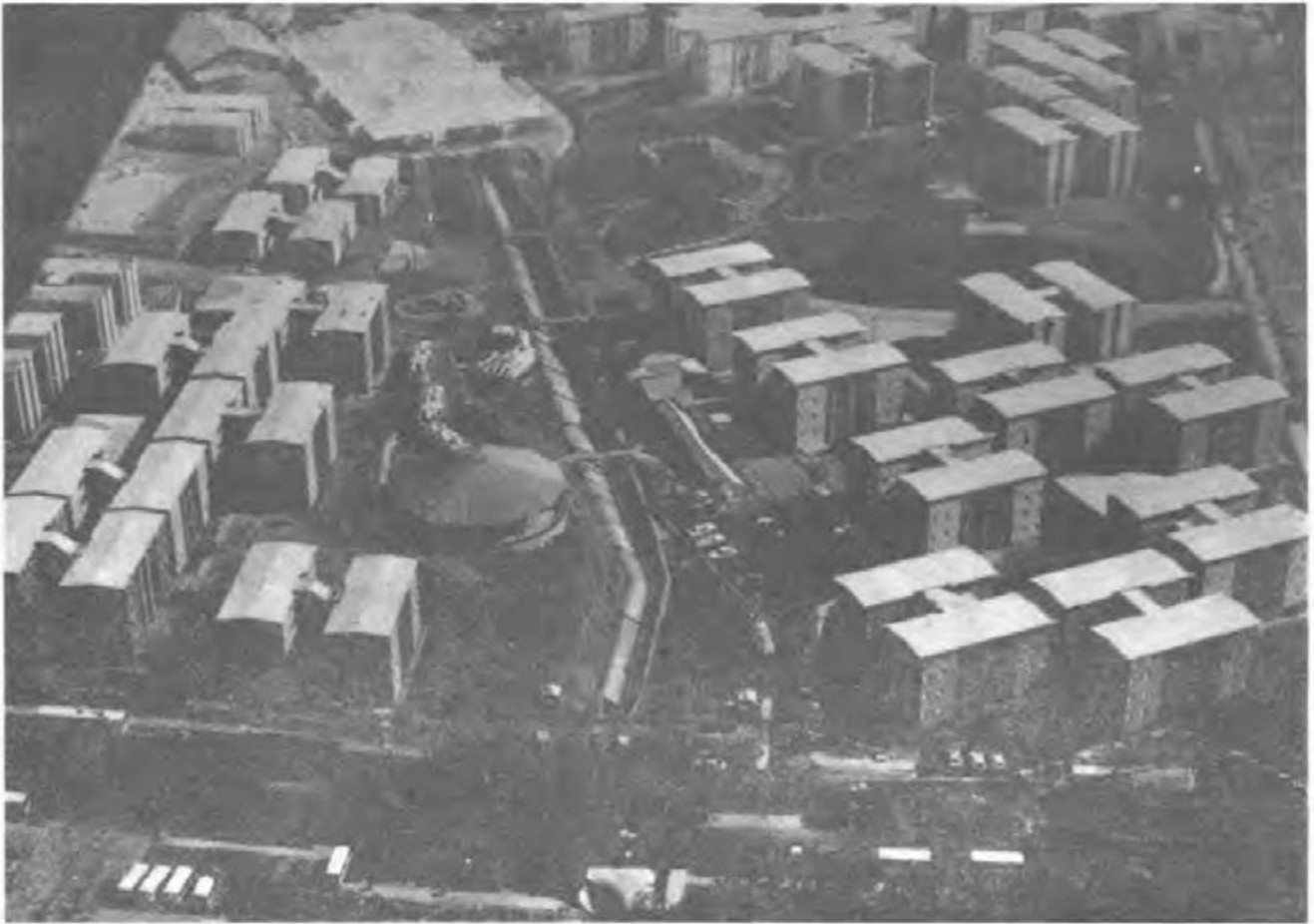
Vista panorámica de la Villa Centroamericana
