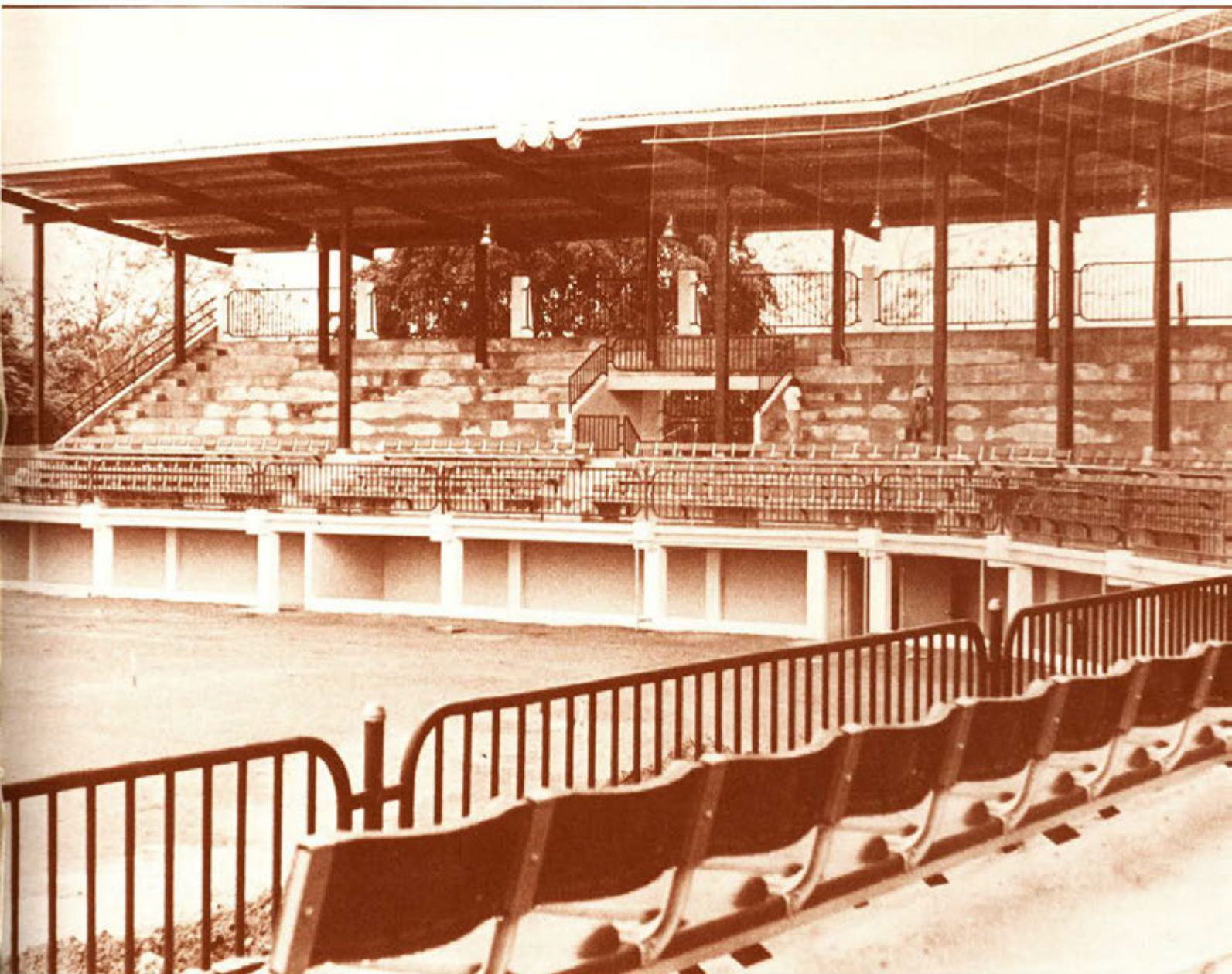
El Parque de Villa Nevarez fué reconstruído, sirviendo para las competencias de Sófbol en la rama masculina. La reconstrucción incluyó la construcción de graderías e instalaciones sanitarias para público y equipos.
