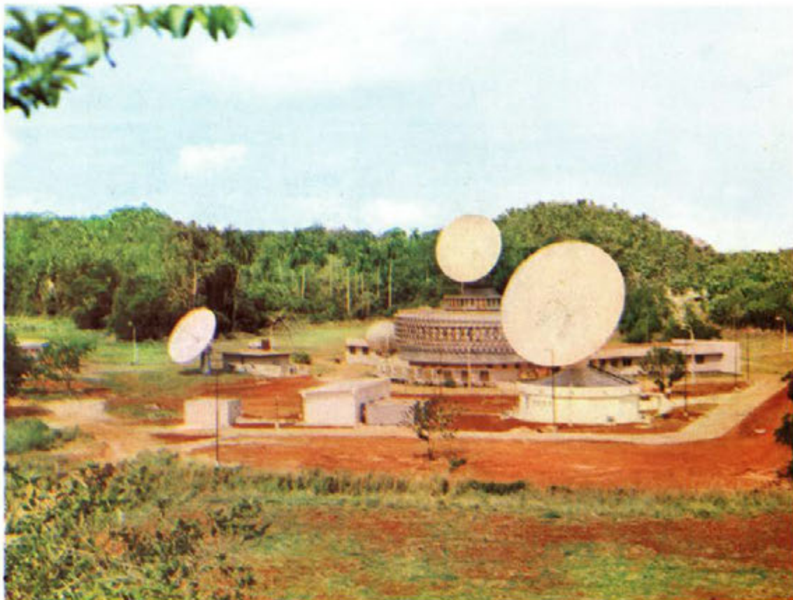
Estación terrena de Jaruco, nexa vital para transmisiones Satellite-Earth Station in Jaruco, vital link for broadcasts
